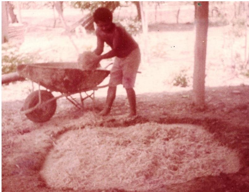
18.- Barro, agua y paja para las paredes y el techo, revalorizamos lo nuestro
