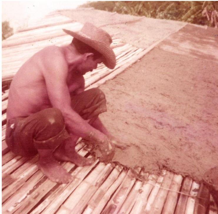
16.- Encima lleva barro, elemento ancestral en la construcción tradicional venezolana
