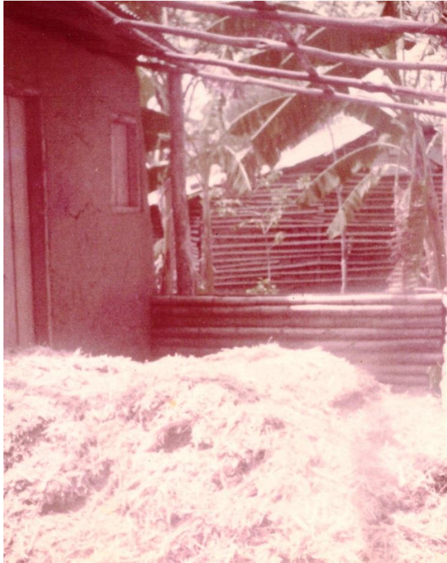
14.- Usamos paja y bagazo de caña mezclados con agua y barro
